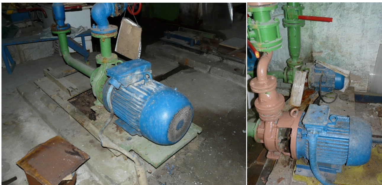
Рисунок 40. Насосное оборудование котельной «Центральная», п. Монетный
