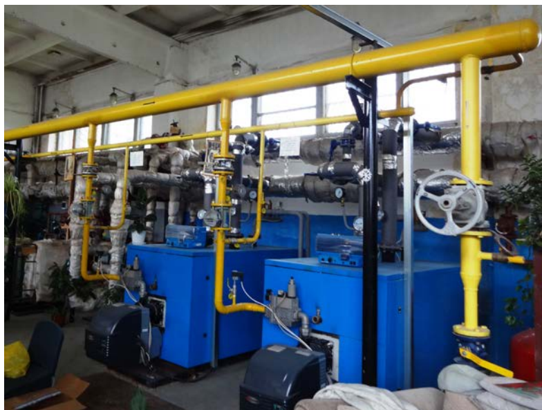
Рисунок 34. Котловое оборудование котельной «Леонтьева, 11-а»
