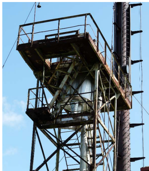
Рисунок 25. Водоподготовительная установка котельной «Еловая»
