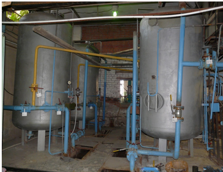
Рисунок 8. Водоподготовительная установка котельной "Южная"
