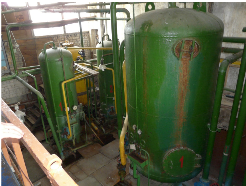
Рисунок 37. Водоподготовительная установка котельной «Центральная», п. Монетный
