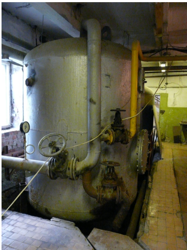
Рисунок 12. Водоподготовительная установка котельной «НБП»
