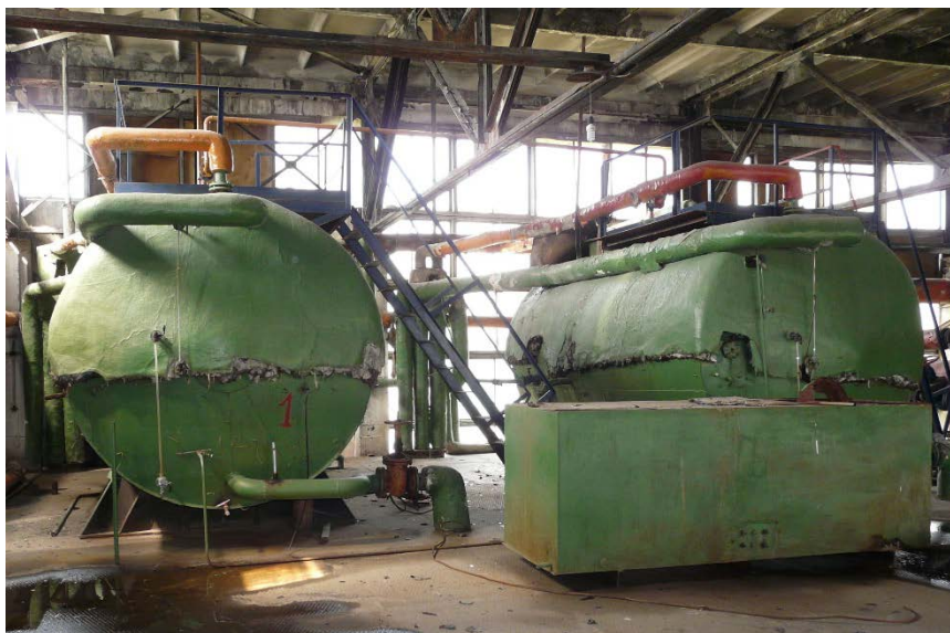
Рисунок 38. Деаэраторы котельной «Центральная», п. Монетный
