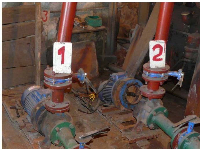
Рисунок 51. Насосное оборудование котельной «п. Солнечный»
