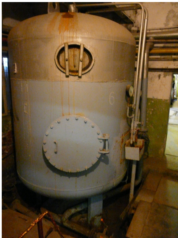
Рисунок 12. Водоподготовительная установка котельной «НБП»
