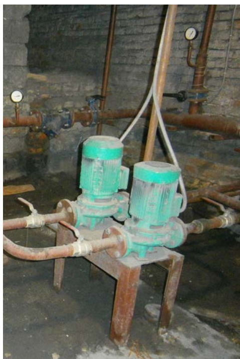
Рисунок 57. Насосное оборудование котельной «Котельная №2»
