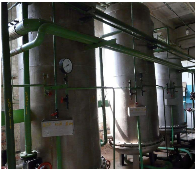
Рисунок 25. Водоподготовительная установка котельной «Еловая»
