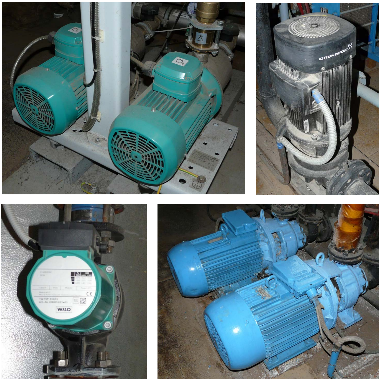
Рисунок 22. Насосное оборудование котельной «Овощное»
