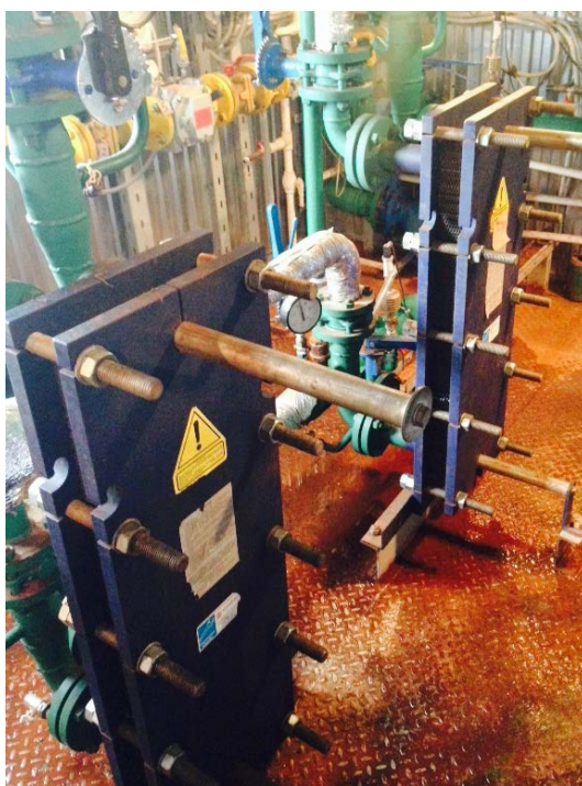
Рисунок 60. Теплообменное оборудование котельной «Сарапулка №1»
