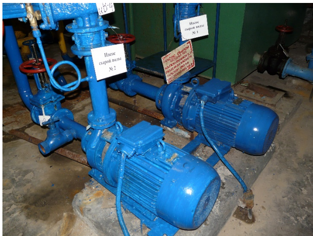
Рисунок 9. Насосное оборудование котельной «Южная»
