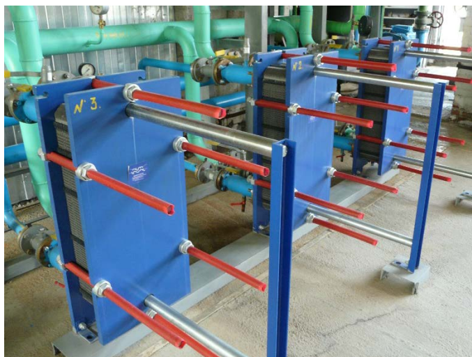
Рисунок 17. Теплообменное оборудование котельной "Шиловка"
