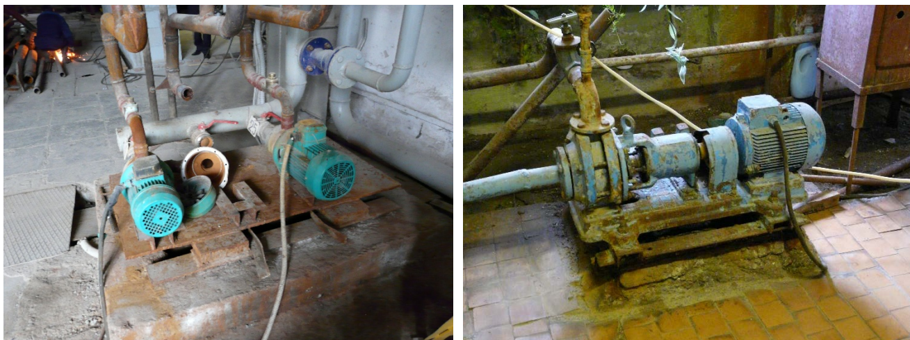
Рисунок 13. Насосное оборудование котельной «НБП»
