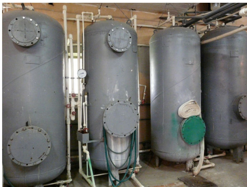
Рисунок 72. Водоподготовительная установка котельной «Транспортников, 41»
