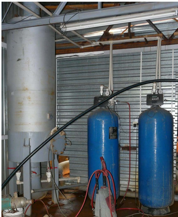
Рисунок 67. Водоподготовительная установка котельной «п. Лосиный ул. Центральная»
