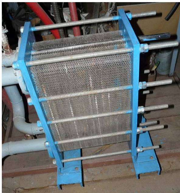
Рисунок 21. Теплообменное оборудование котельной «Овощное»
