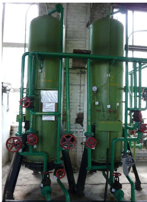
Рисунок 16. Водоподготовительная установка котельной «Шиловка»
