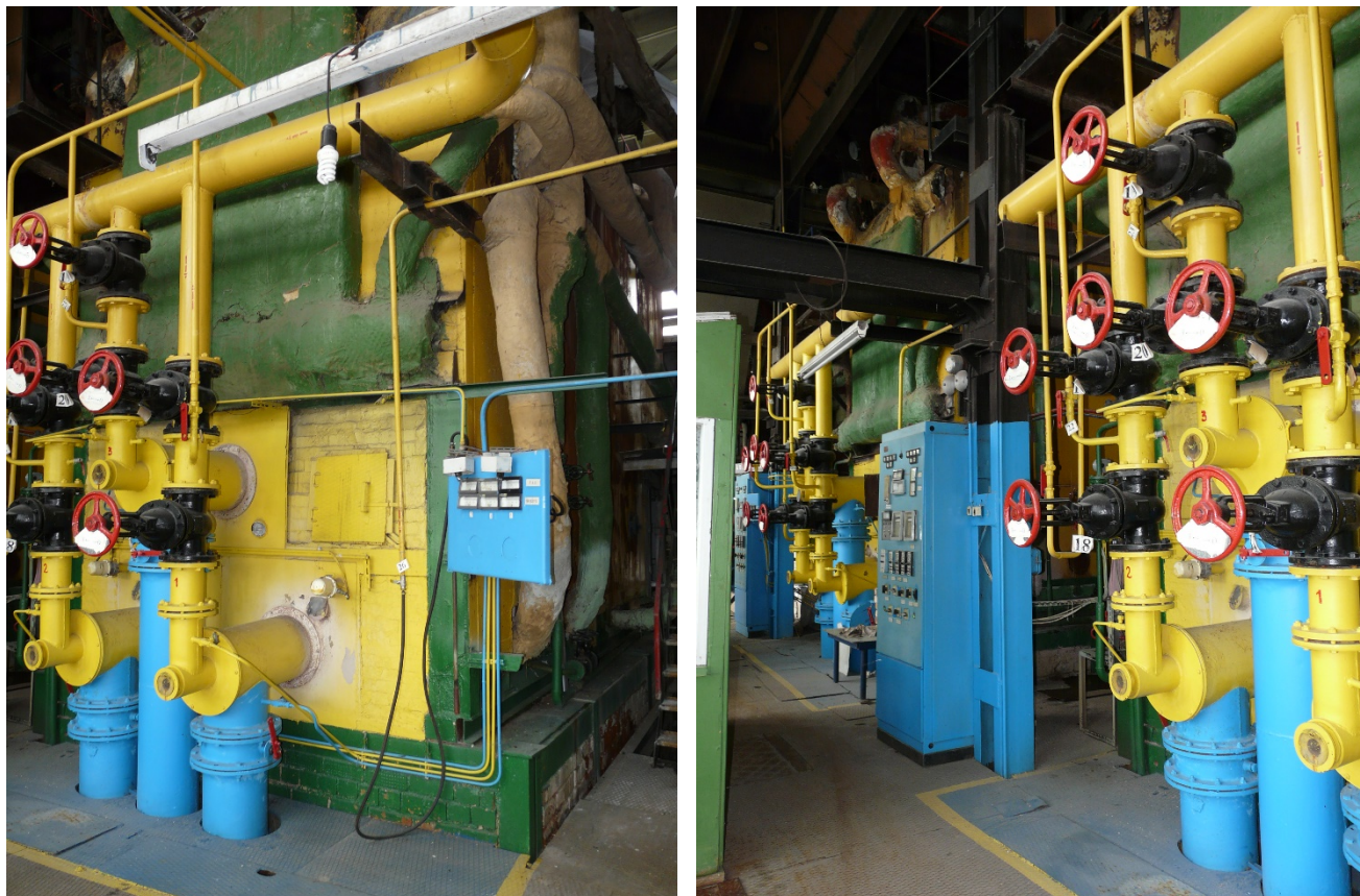
Рисунок 36. Котловое оборудование котельной «Центральная», п. Монетный
