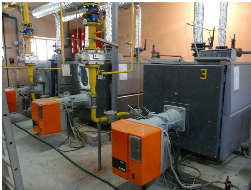
Рисунок 71. Котловое оборудование котельной «Транспортников, 41»
