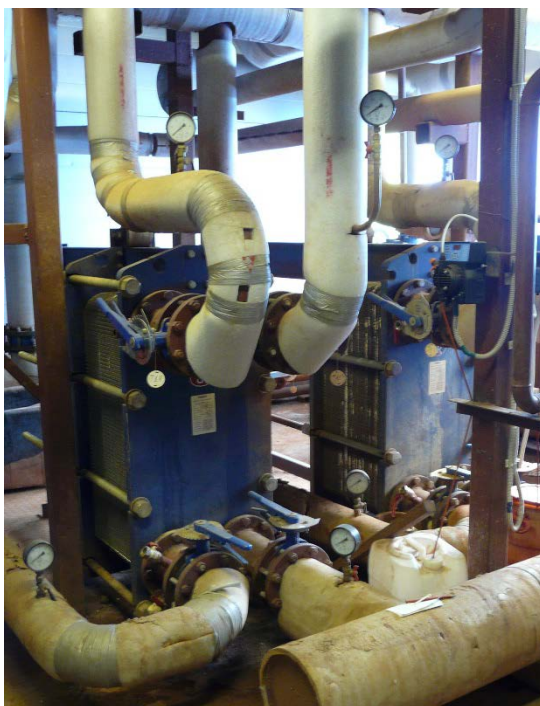
Рисунок 45. Теплообменное оборудование котельной «п. Монетный»
