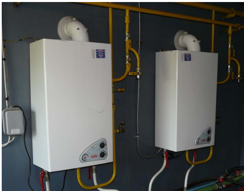
Рисунок 31. Котловое оборудование котельной «Металлистов, 10»
