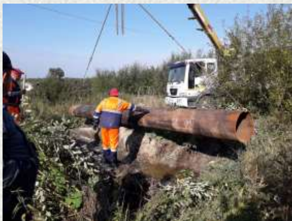
Замена трубы под дорогой на ул. Калинина
